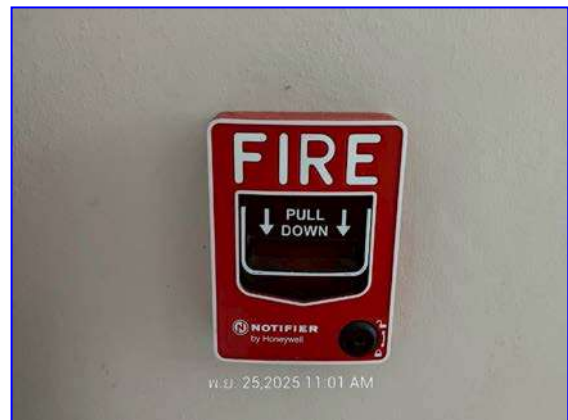
รูปที่ 2.20 อุปกรณ์ส่งสัญญาณเตือนเพลิงไหม้
