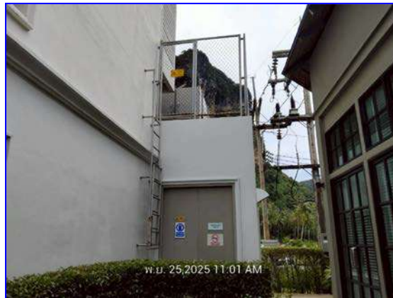
รูปที่ 2.10 หม้อแปลงไฟฟ้าขนาด 2,000 kVA
