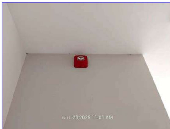
รูปที่ 2.20 อุปกรณ์ส่งสัญญาณเตือนเพลิงไหม้
