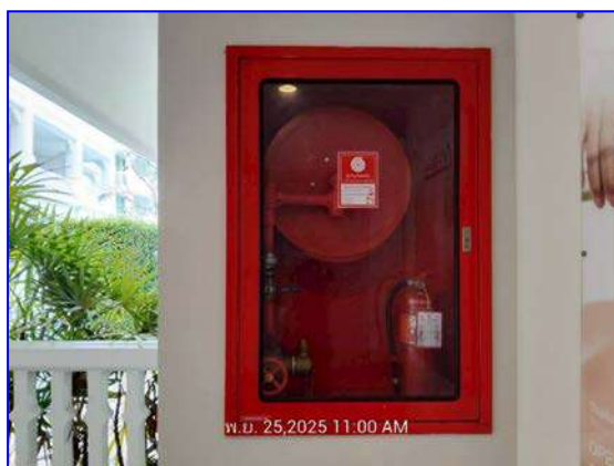
รูปที่ 2.18 ตู้เก็บอุปกรณ์ดับเพลิง
